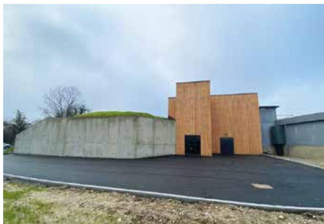
Le nouveau réservoir comprend un réservoir semi-enterré de 1 500 m<sup>3</sup> et une chambre de vannes attenante.
