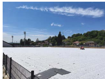
Un revêtement identique au stade Paul-Chastel va être posé.
